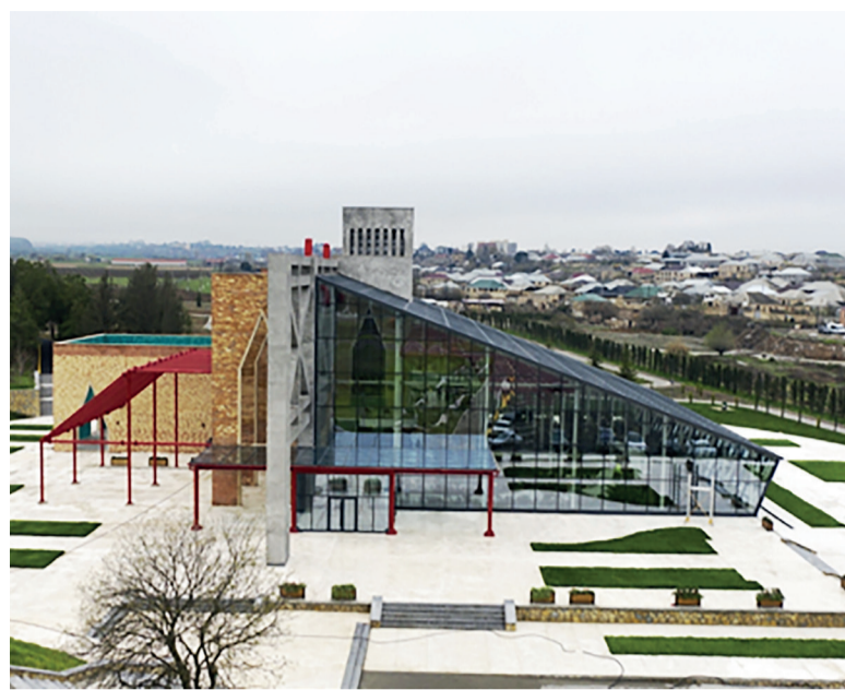
Все объекты сооружаются с использованием новейших архитектурных методов
